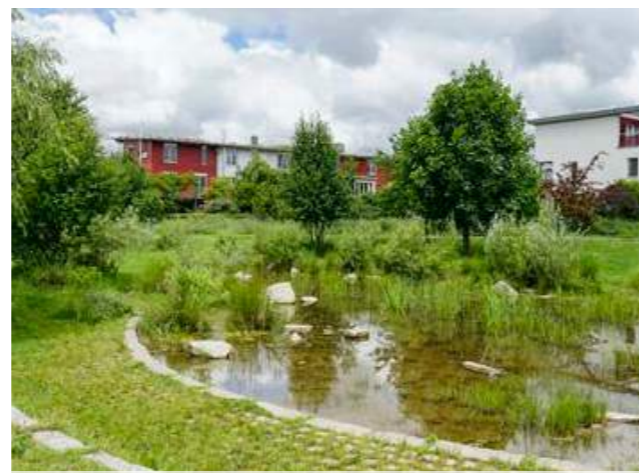
Figure 6.127 Retention Pond Freiburg Rieselfeld © Arthur Wegmann Fotografie
